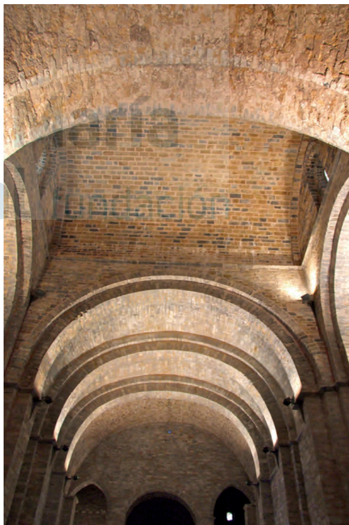
Bóvedas del crucero
